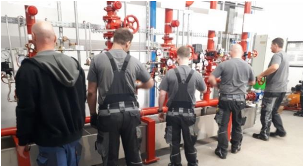
Ausbildung an der Systeex-Demoanlage
